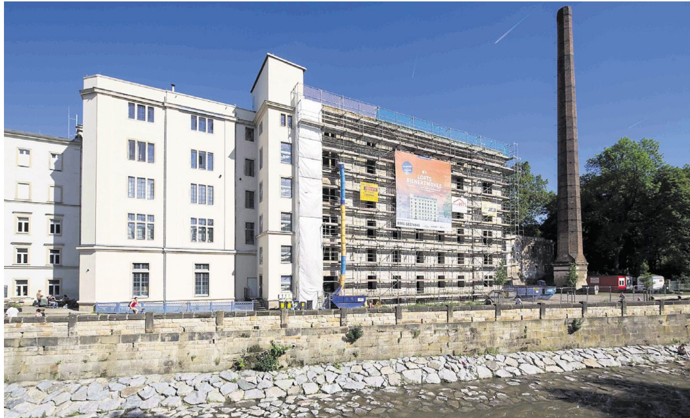
Die Sanierungsarbeiten an der Bienertmühle sind in vollem Gange. Bis Ende dieses Jahres sollen die 46 Wohnungen fertig sein. Auch wenige Hundert Meter entfernt, am Bienertpark, soll ab Juli ein neues Wohnhaus gebaut werden. Foto: Steffen Füssel
