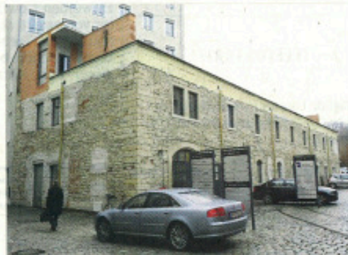
Der alte Speicher im Hof der Mühle bekommt eine neue Fassade und ein Sockelgeschoss. Foto: André Wirsig
